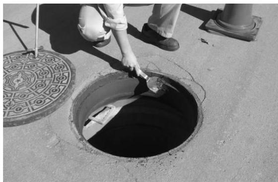
3. マンホール断熱蓋シートを水平に設置して下さい。
