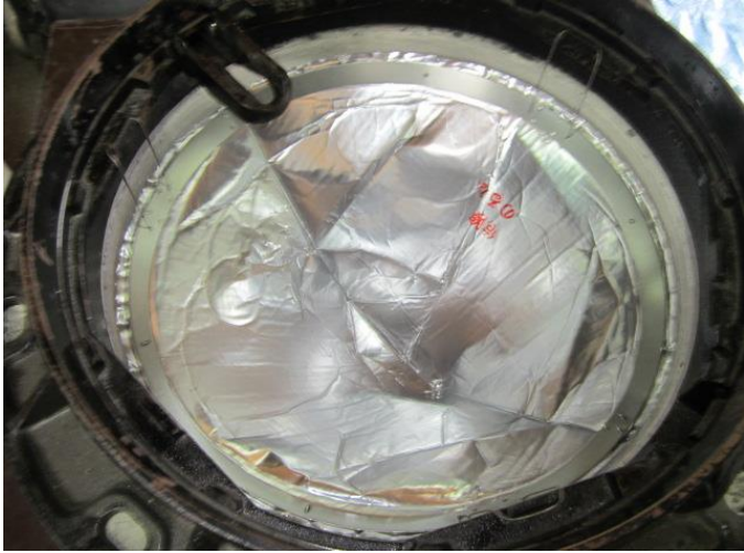
① マンホールに断熱シート取付けた状態
