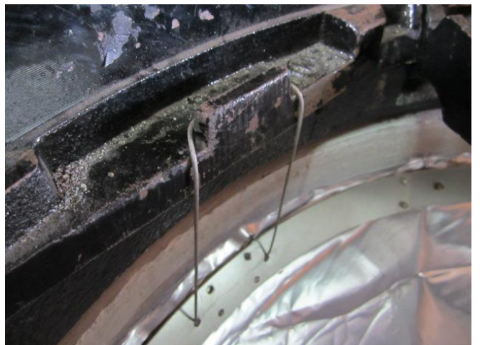
③ マンホール鉄枠の凸部にワイヤーを3箇所掛け、シートとマンホールの隙間がなくなるように手で押さえて取付ける。
