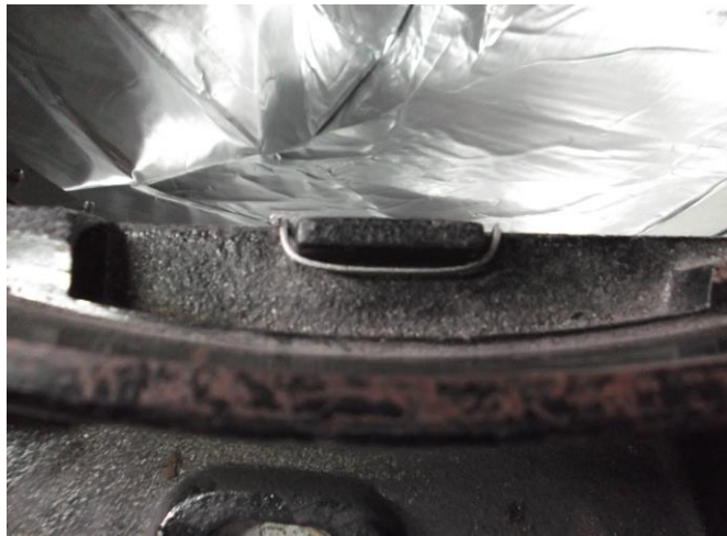
③ マンホール鉄枠の凸部にワイヤーを3箇所掛け、シートとマンホールの隙間がなくなるように手で押さえて取付ける。
