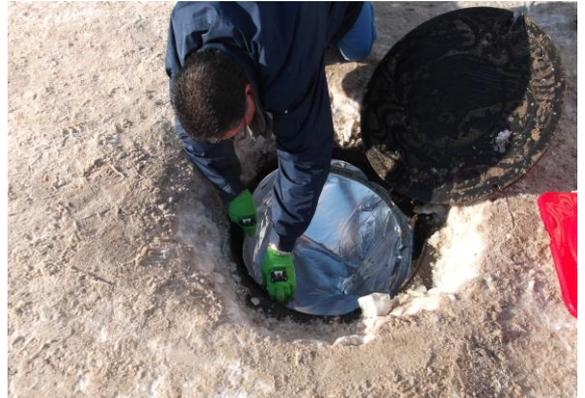
5. マンホール鉄枠の凹凸部に吊りワイヤーを3箇所引っ掛けてください。
