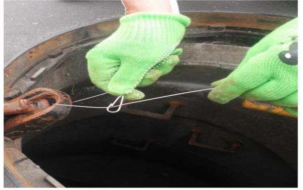
3. 断熱シートを円錐形に整え、排出口が閉じていることを確認し、斜めにして挿入してください。
