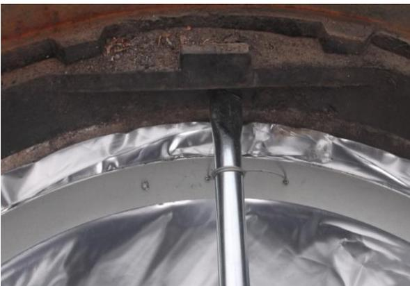
6. 突っ張り棒の中央部握り、付属のスパナでジャッキを締め付けコンクリート面に固定してください。
