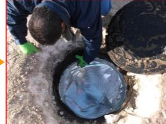
④断熱シートとマンホールの隙間が無いように取付ける。
