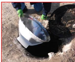
①鉄蓋を外し、断熱シートを斜めに挿入する。
