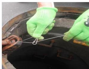
②断熱シートの落下防止フックをマンホールに取り付ける
