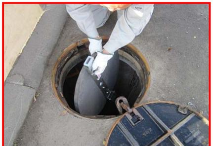
③ 鉄枠の凸部に吊り金具を掛ける
