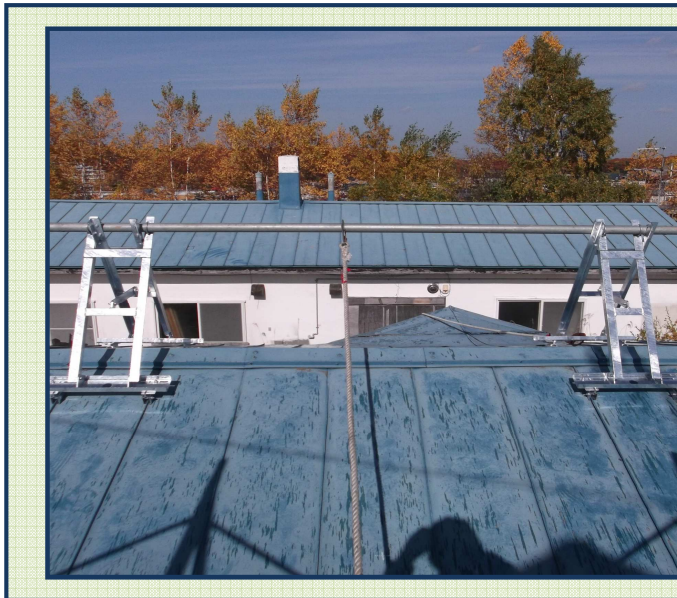
雪下ろしアンカー取付図
